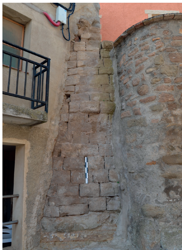
Figura 13. Cara externa del posible cubo defensivo de planta levemente curva, asentado sobre la cantera de arenisca (plaza Mayor nº 7 de Bolea). Esta fábrica a la vista, de sillar de módulo pequeño-mediano asentado a soga en hiladas pseudoisódomas, obedece a una reforma que forraba la obra andalusí primitiva de sillares a tizón (vid. Figura 12).
