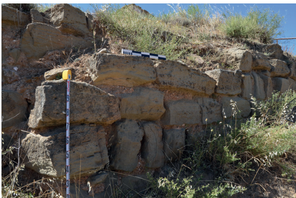
Figura 2. Detalle del tramo norte del basamento de la ladera septentrional del cerro del Castillo de Bolea, de aparejo de aire poligonal y probable cronología altomedieval andalusí.
