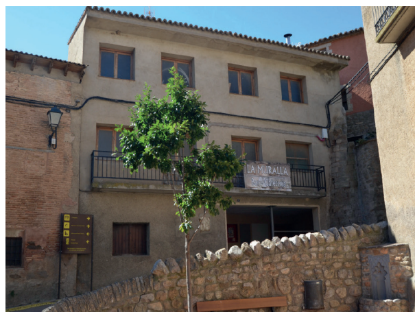
Figura 6. Fachada noroeste de la finca de plaza Mayor nº 7 de Bolea, bar restaurante “La Muralla”, en donde se hallaron los restos objeto del presente estudio. En el solar contiguo a la derecha de la imagen se llevaron a cabo otros descubrimientos en el verano de 2017.
