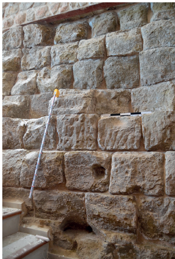
Figura 10. Detalle del aparejo andalusí a tizón de la muralla de plaza Mayor nº 7, una vez restaurado. Zarpa e hiladas inferiores del alzado.
