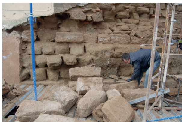
Figura 8. Proceso de descubrimiento del paño de muralla andalusí de plaza Mayor nº 7 de Bolea (fotografía J. C Azor).
