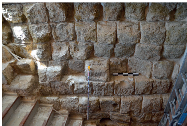
Figura 9. Fragmento de paño de la muralla andalusí de la plaza Mayor nº 7 una vez restaurado, en el que se aprecian la zarpa escalonada de la base y la disposición de los bloques a tizón.
