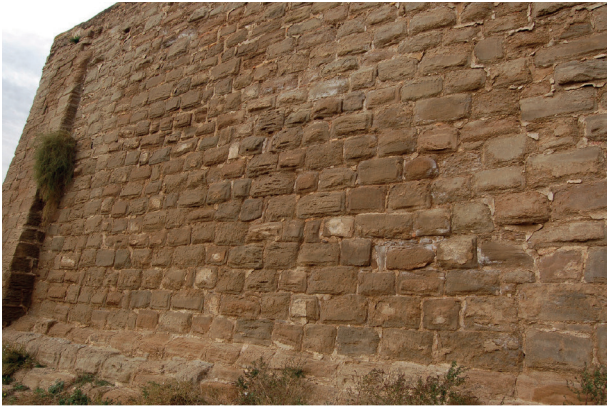
Figura 1. Vista del muro sur de aterrazamiento de la ladera de la Colegiata de Bolea, tramo oriental, construido en época Moderna-Contemporánea. Las figuras, si no se indica otra cosa, son del autor.
