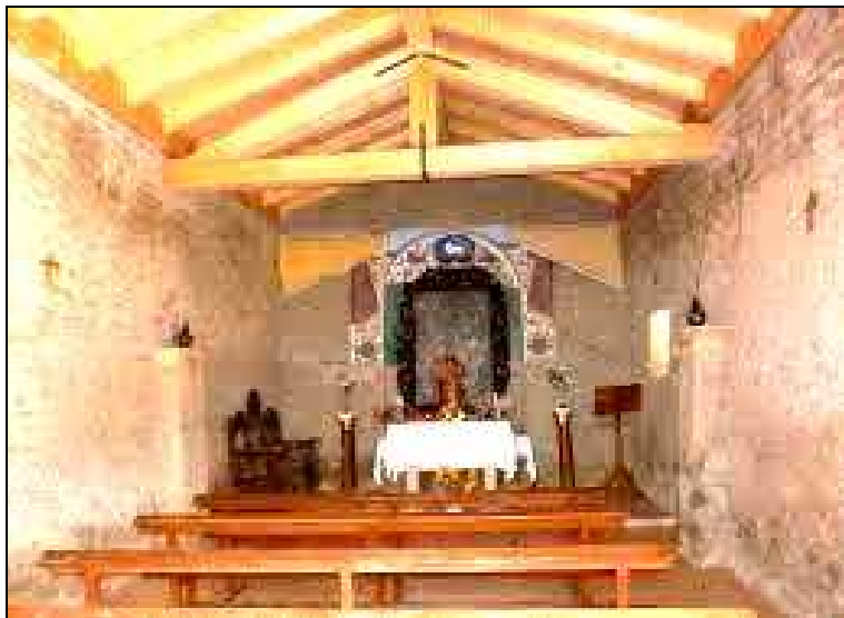
Reformas llevadas a cabo en la techumbre de la ermita. (Foto: P.Plano)
