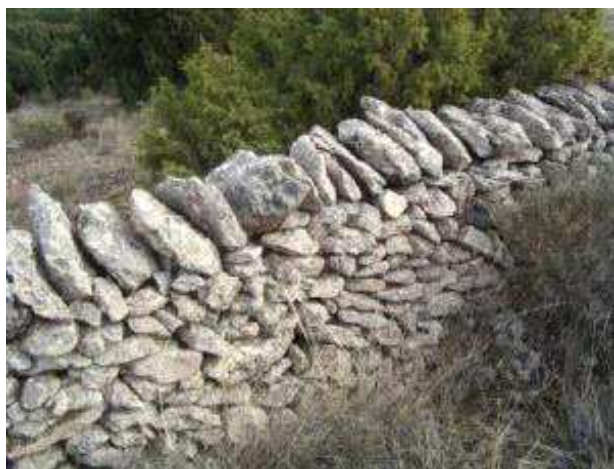
Pared típica de los caminos y cercados
